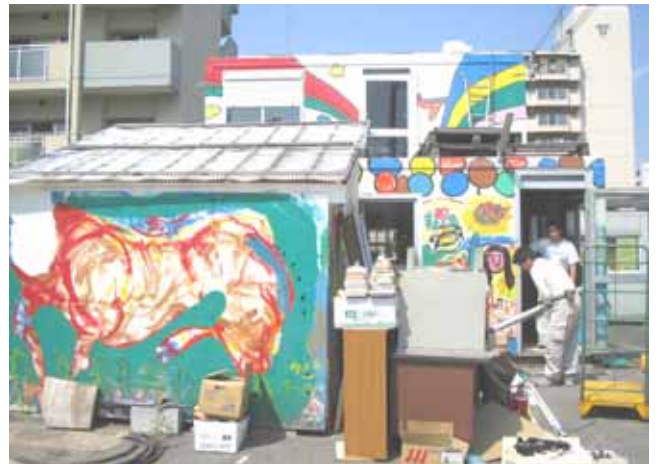
▲ 05年6月30日スタジオ5解体前
