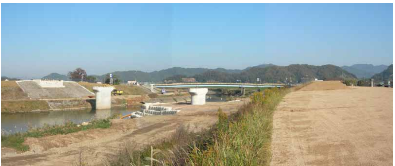
豊岡市出石町の鳥居橋の再建中の様子（2009年11月7日現在）
