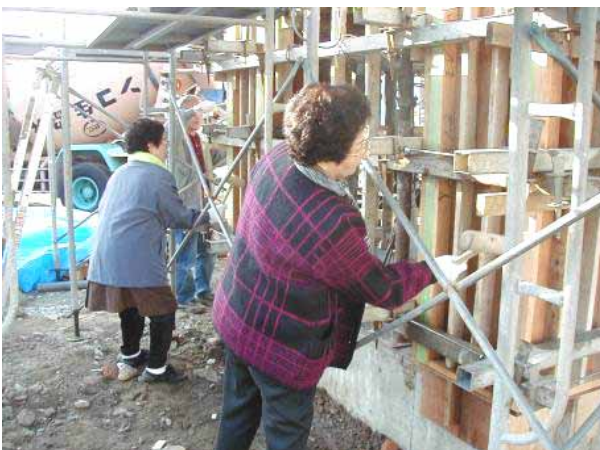
慰霊碑コンクリート打設
