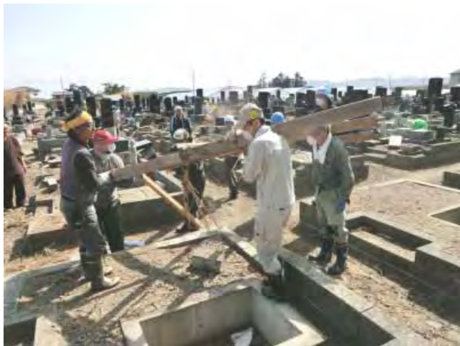
▲ 2011年5月6日 宮城県亘理町での復旧作業の様子
