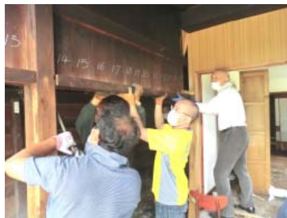
台日協力しながら解体工事
