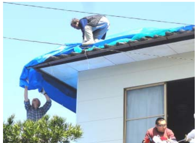
被災家屋の屋根へブルーシート張り(嘉島町)
