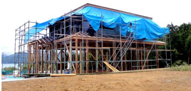
住宅建設が進みつつある立浜地区
